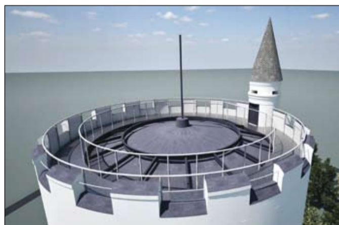
A víztorony belső terében biztonságos lépcsőház, a tetőn pedig kilátóterasz épül
