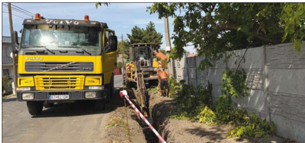
V rámci druhej etapy bude vymenených približne 610 metrov vodovodného potrubia.
